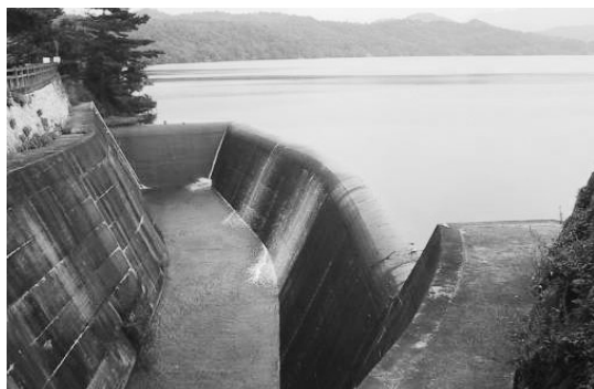
図1 満濃池の余水吐を越流する水
