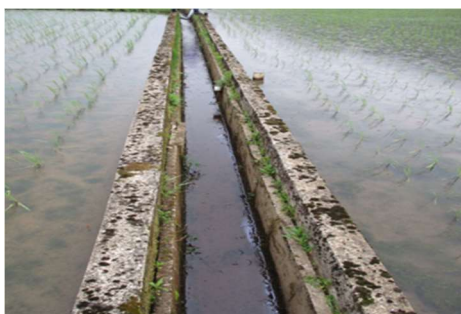
図 2-2 水田における 3 面コンクリート水路
