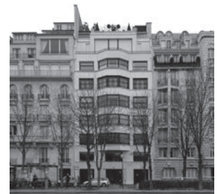
図21 オルセー河岸の集合住宅 (1930)
