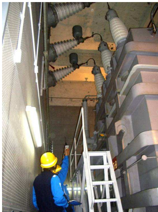
図 4.6 簡易型部分放電診断の作業風景写真
